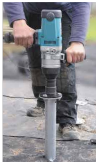
L'adaptateur 41 mm assure la connexion entre la machine (boulonneuse, visseuse) et la vis de fondation.
