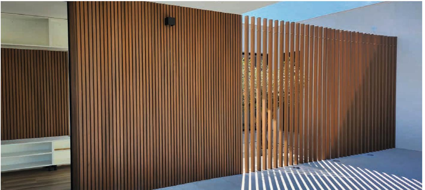
WEO® Brise-Soleil sind Konstruktionselemente, die den Lichteinfall regulieren sollen. Ihr verstellbarer Abstand beeinflusst die direkte Intensität der Sonneneinstrahlung. Sie eignen sich für Fassadenverkleidungen, dekorative Anwendungen und setzen optische Akzente. Brise-Soleil ist allerdings nicht für konstruktive Zwecke zugelassen und besitzt keine statische Zulassung.
