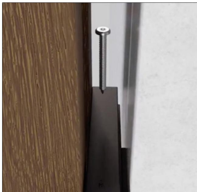
**ÉTAPE 6** Vissage de l'agrafe ou du rail sur le rail support à l'aide de la vis auto-perceuse inox A2 5.5x50mm FD1223/FC2933 (ou 5.5x32mm FD1155/FC2626) et d'un embout allongé.
